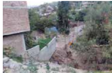
figura 20. Barrio Cuchipampa, asentado en la quebrada Quinuapata
