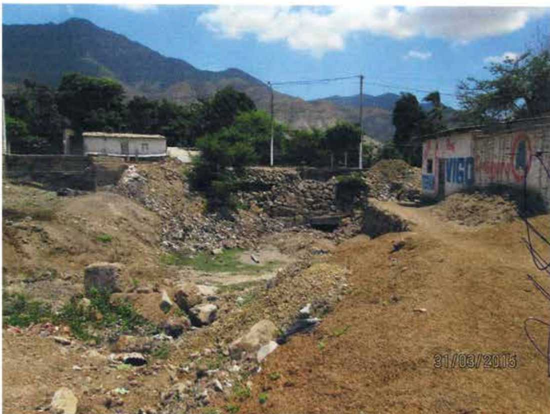
FOTOGRAFIA N° 06: ALCANTARILLA DE DESFOGUE DE LA QUEBRADA LOS CASTROS COLMATADA CON SEDIMENTOS.
