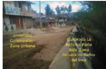
figura 08. Localidad Baños del Inca al borde la quebrada La Retama
