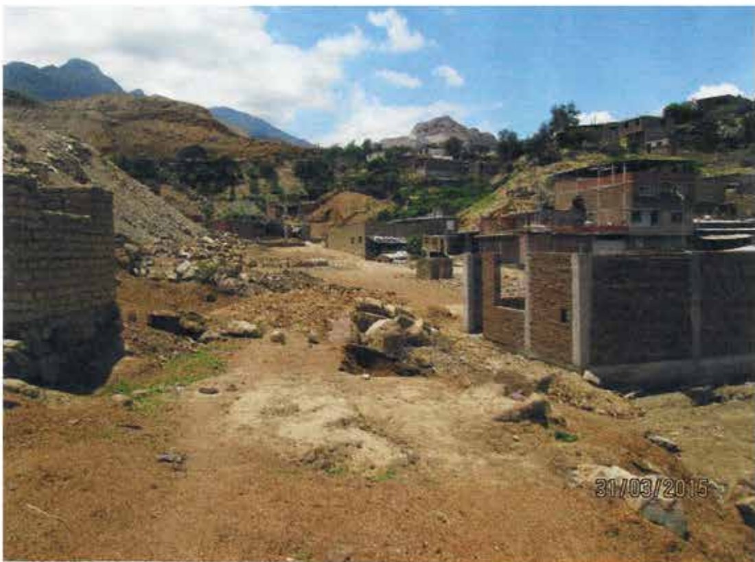
FOTOGRAFIA N° 05: CAUCE DE LA QUERADA CON CASAS RECIENTEMENTE CONSTRUIDAS.
