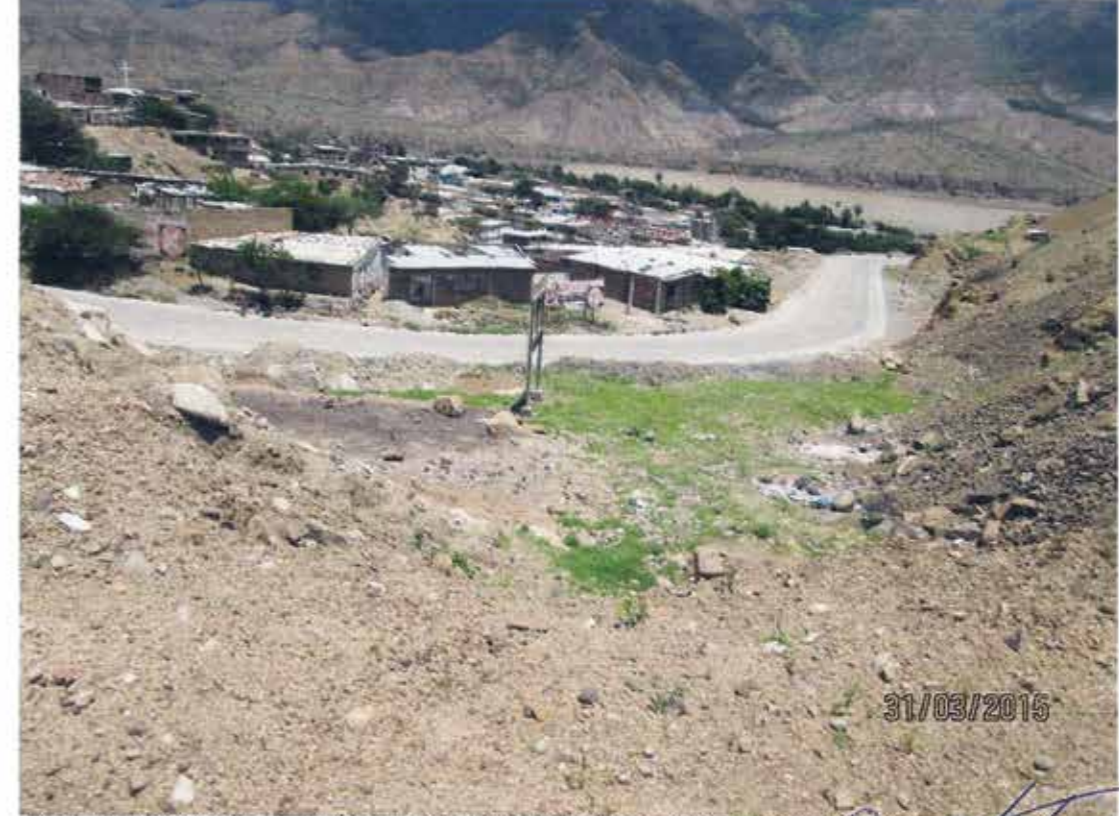
FOTOGRAFIA N° 02: VISTA DEL CAUCE DE LA QUEBRADA LOS CASTROS- OBSTACULOS DE VIVIENDAS
