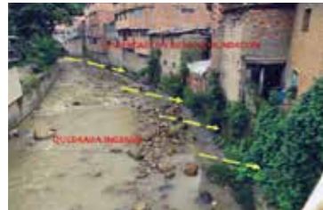
figura 09. Localidad Pedro Ruíz Gallo, al borde la quebrada Ingenio
